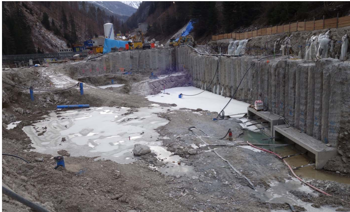
Ankerungsarbeiten Baugrube Wehranlage
