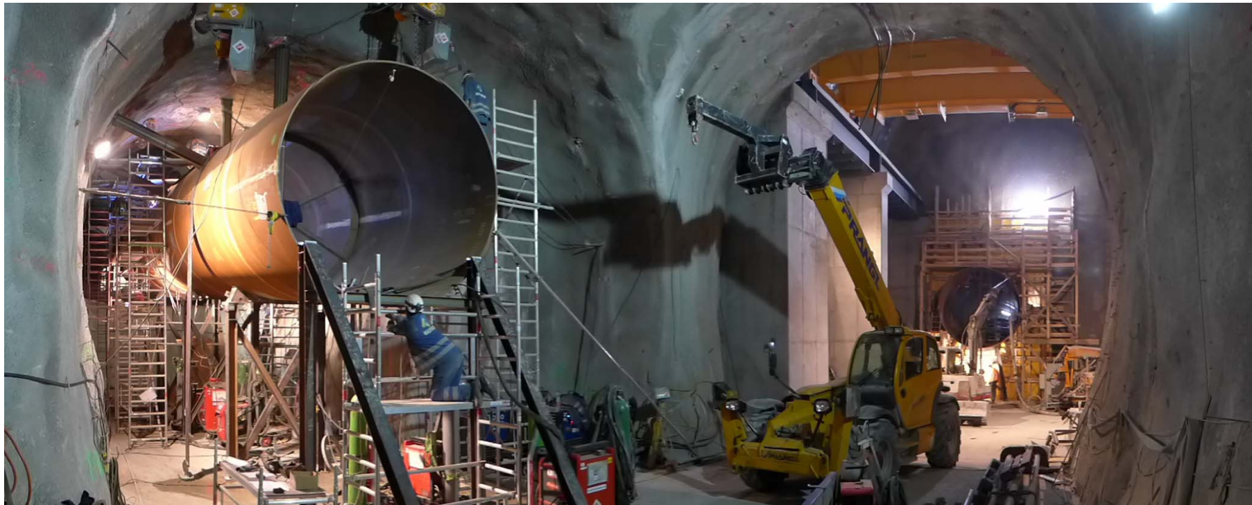
Apparatekammer Abzweig zum Wasserschloss, rechts Druckrohleitung in den Schrägschacht
