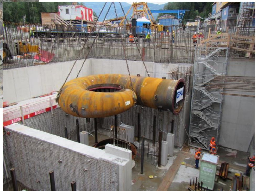
Montage Turbinenspirale
