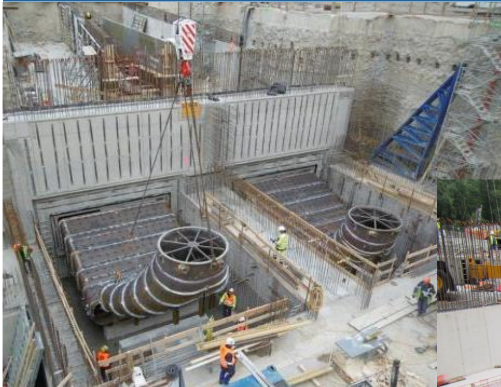
Montage Saugrohr
