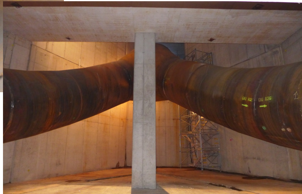
Verteilrohrleitung
