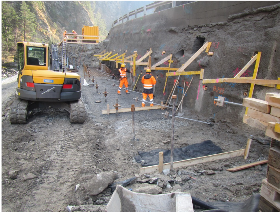
Herstellung Stützmauer durch TBA
